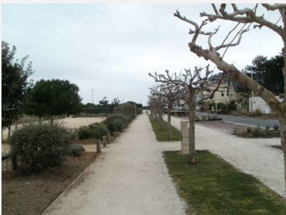
Aménagement d'un cheminement © TECAM
